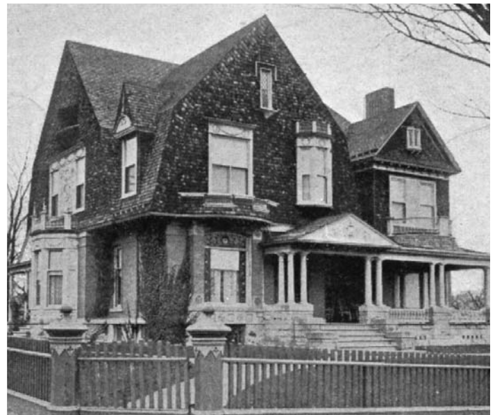
4 N. Jackson St., post-1897 remodel
